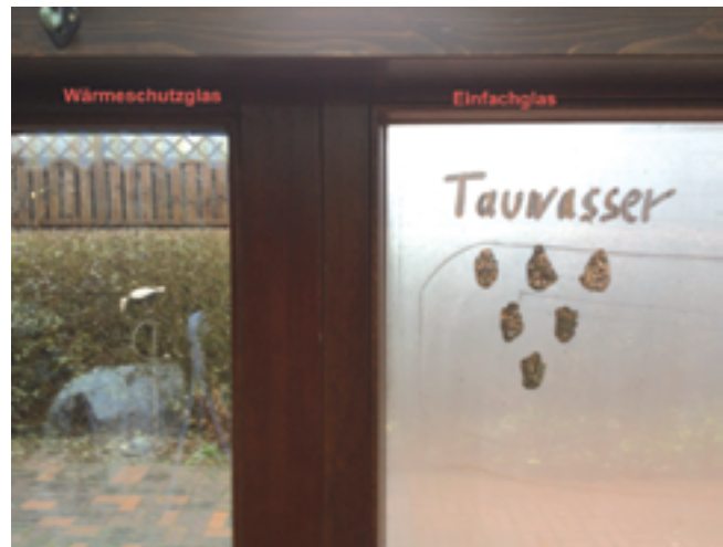
links: Wärmeschutzverglasung rechts: Einfachverglasung
